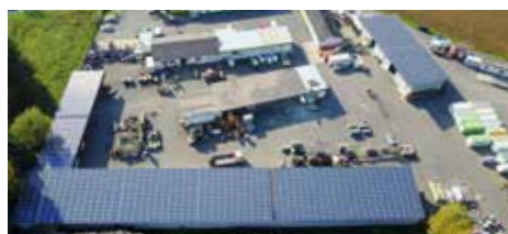
PV Bauhof Mandlbauer (2018) ~400kW auf gewerblichem Gebäude mit 100% Bürgerbeteiligung
