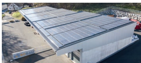
PV SO BAU (2018), 199 kW, auf gewerblichem Gebäude
