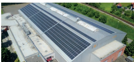
PV Bad Gleichenberger Halle (2017), 195kW auf der Veranstaltungshalle mit 100% Bürgerbeteiligung
